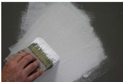
Fondo strutturante: preparare il supporto con una mano di fondo strutturante.
