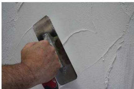
Applicare un primo strato di Prestigio utilizzando una spatola in acciaio inox in modo uniforme sino a copertura totale del supporto (max 3mm spessore)
