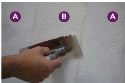
Dopo aver posizionato i nastri sulla superficie, in modo da tracciare delle linee guida, applicare il prodotto sulla fascia B. Ad asciugatura avvenuta procedere con le fasce A.
